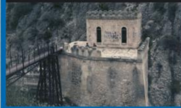
Estado de la caseta y el puente a mediados de los años 70
