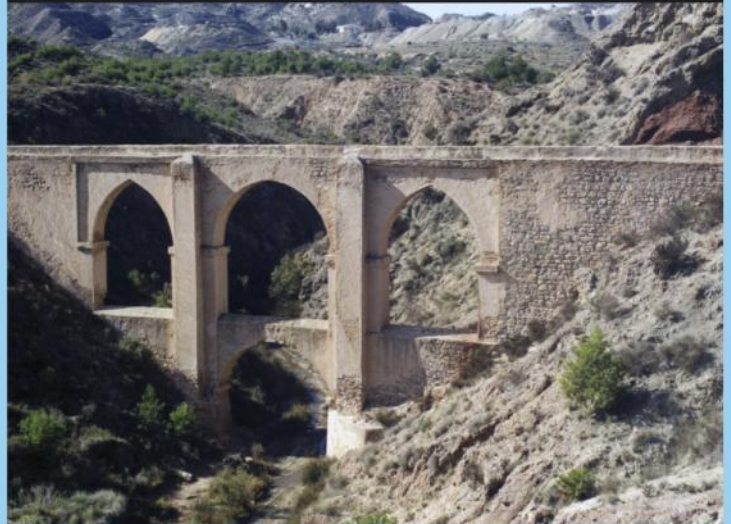
Acueducto de los Cuatro Ojos
