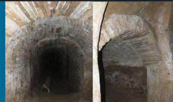
Bóveda de cañón forrada de ladrillo macizo en una de las galerías transversales y rosca del arco del acceso
